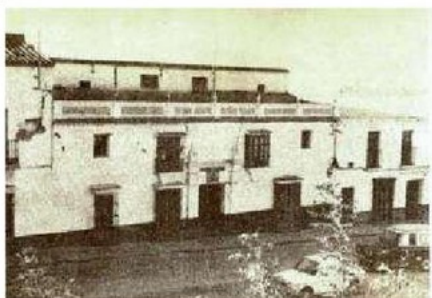
Foto borrosa de la fachada del antiguo cuartel de la Guardia Civil
